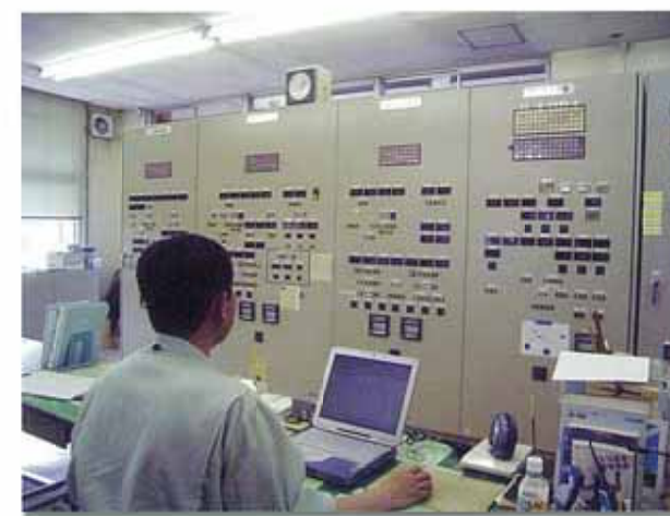
浄水場内の運転管理施設
