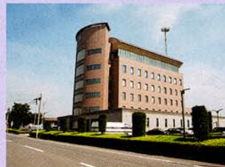
●サーバーセンター (群馬総合ガードシステム内)
