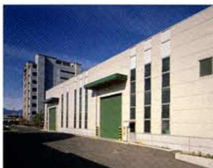
ヤマト加工センター【総合設備工場】
