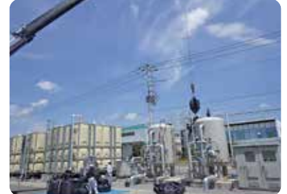
ろ材交換工事
