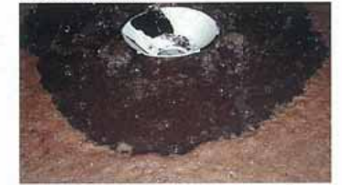
ろ材の空気洗浄状況
