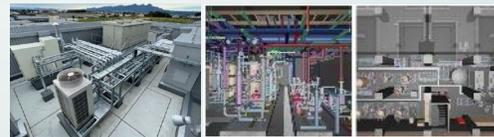
自社工場での配管のプレハブ加工・ユニット化により設備の高品質化と工期短縮を実現
