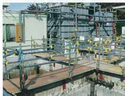
改修中の本設
