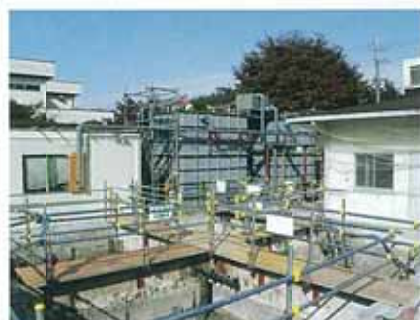
改修中の本設
