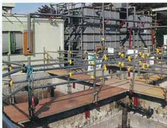
改修中の本設
