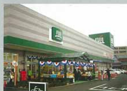
Fuji橋戸店 (NEDO事業)
